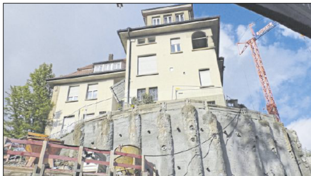
So tief war die Baugrube für den Anbau des Landratsamts. Der Untergrund rund um die Villa Roller hat man mit Stützpfeilern abgestützt.
